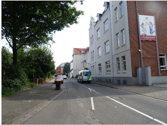
Marienstraße schadhafter Zustand / mangelnde Aufenthaltsqualität
