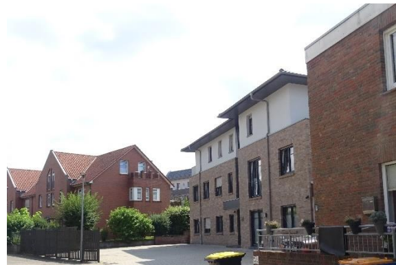
Mehrfamilienhäuser am Spengepielplatz
