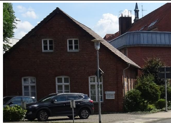
Dienstwohngebäude an der JVA II (An der Propstei 14)
