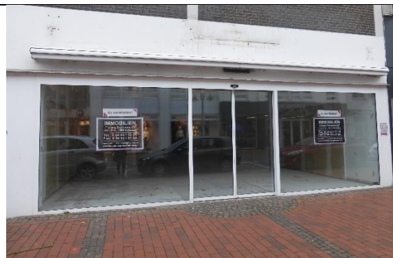
leerstehendes Ladenlokal – Große Straße
