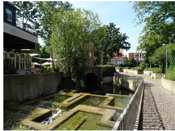
Im Betonbett geführter Wasserlauf
