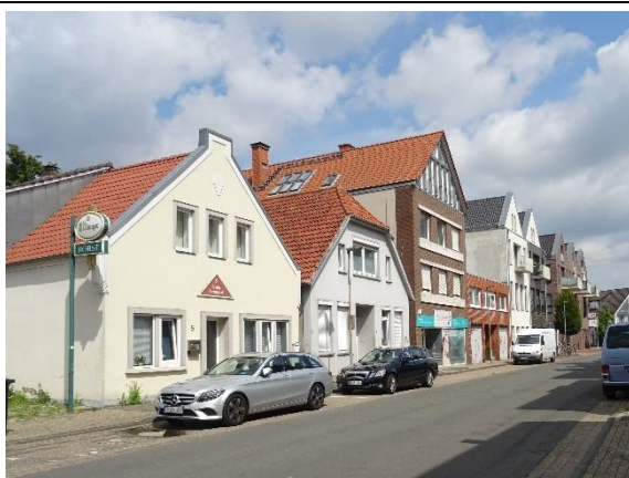
Geschäfts-/ Wohngebäude Klingenhagen
