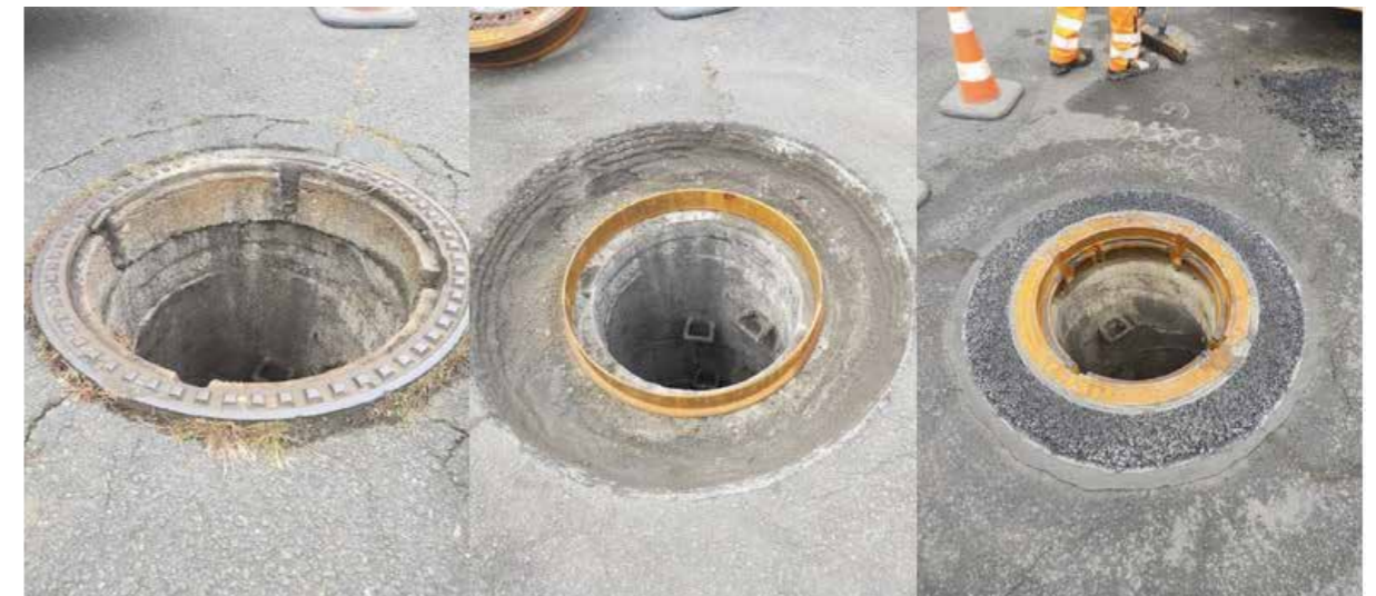
Schachtdeckel vor, während und nach der Sanierung
