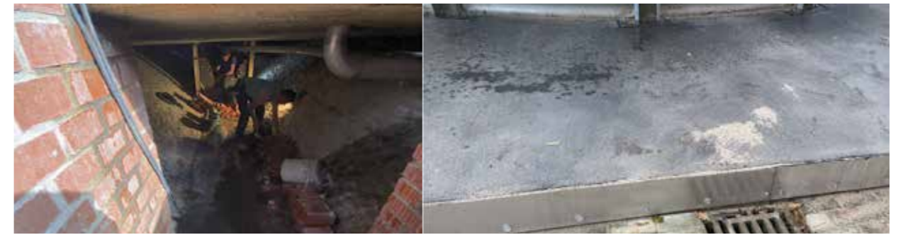
Erstellen des Schachtes unter dem Behälter, Neue Beschichtung auf der Bodenplatte
