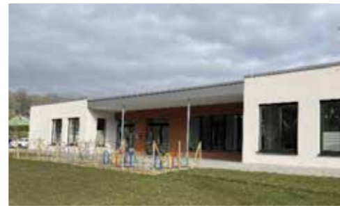
Kita Langförden Haupteingang
