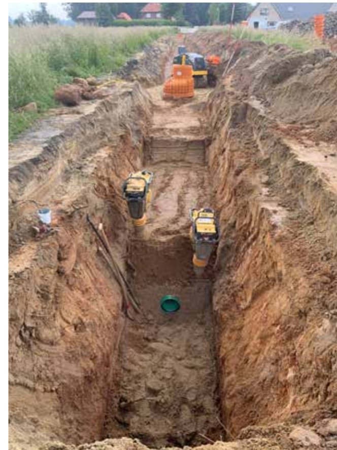
Mühlendamm - Kanalbauarbeiten_Schmutzwasserkanal in der Straße Mühlendamm (Juni 2022)
