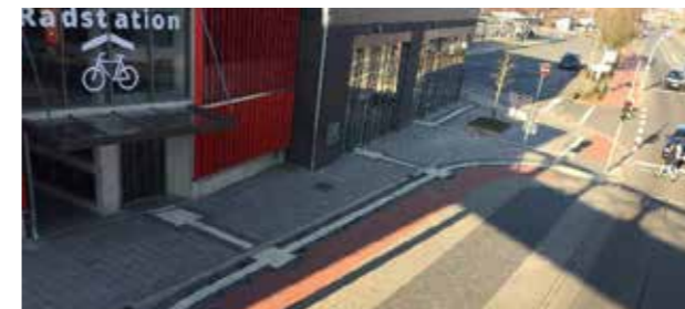
Mobilitätsstation - Taktiles Bodenleitsystem entlang der Straße „An der Gräfte“ (Dez. 2019)
