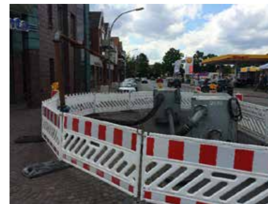
Hochleistungspumpen fördern das Schmutzwasser während der Kanalsanierung in die aufgeständerte Druckrohrleitung
