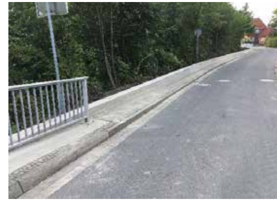
Betonwand „An der Wassermühle“
