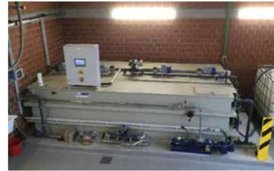
Bild: Flockungsmittelansatzstation
