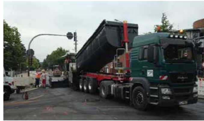
Kreuzung Ravensberger Straße Asphalteinbau Deckschicht (Juli 2019)
