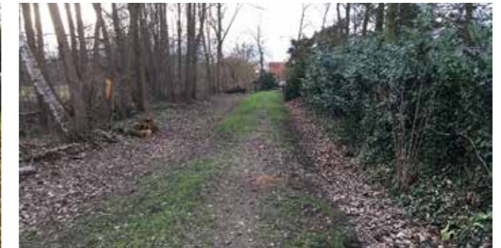
HW-Schutzwall entlang Privatgrundstücke Philosophenweg
