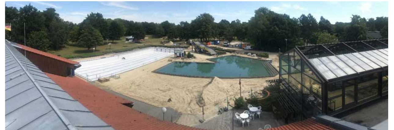
Sanierung des Freibades
