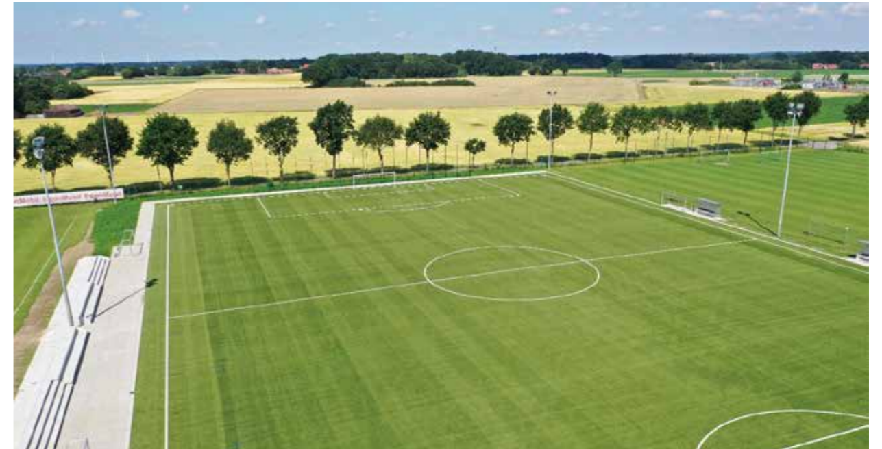
Neubau eines Kunstrasenplatzes am Oyther Berg
