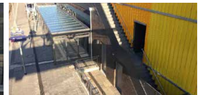
Mobilitätsstation - Taktiles Bodenleitsystem entlang des Bahnsteiges (Dez. 2019)
