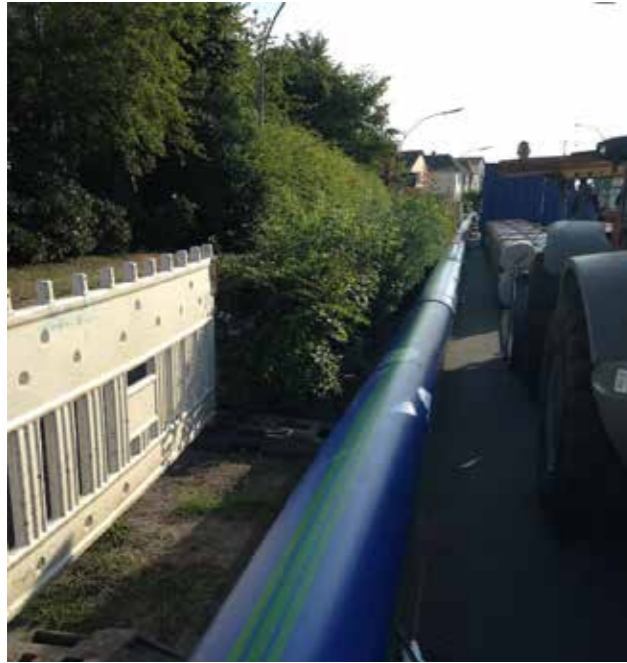
Oyther Straße - Stumpfgeschweißte Trinkwasserhauptleitung vor dem Einzug (Juli 2019)
