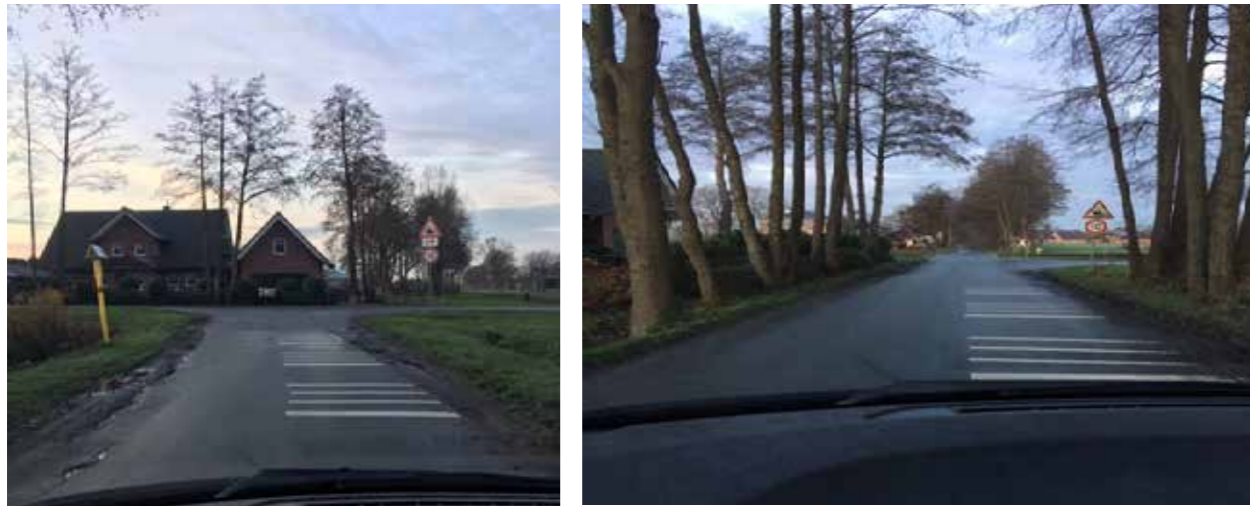
Abbildung 2 Rüttelmarkierung Hagen-Ringstraße Abbildung 3 Rüttelmarkierung Hagen-Ringstraße
