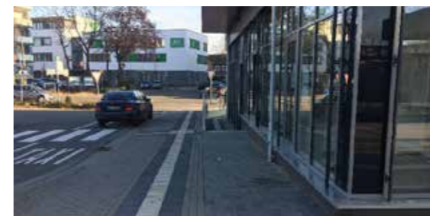
Mobilitätsstation - Taktiles Bodenleitsystem entlang des Taxistandes (Dez. 2019)
