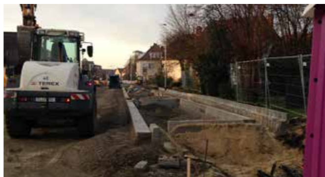
Oyther Straße - Bordanlage Nordseite (Dezember 2019)
