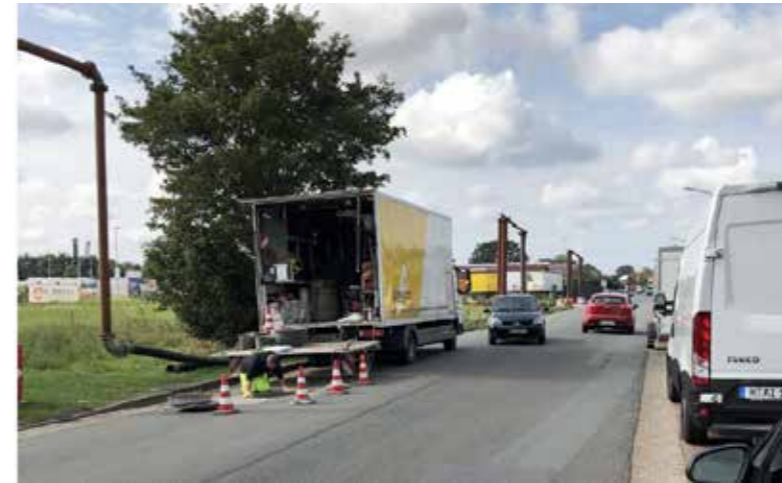
Bild links: Platzsparende Baustelleneinrichtung bei geschlossenen Bauverfahren
