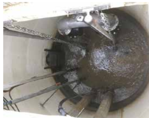
Mit GFK-Platten sanierter Zulaufschacht
