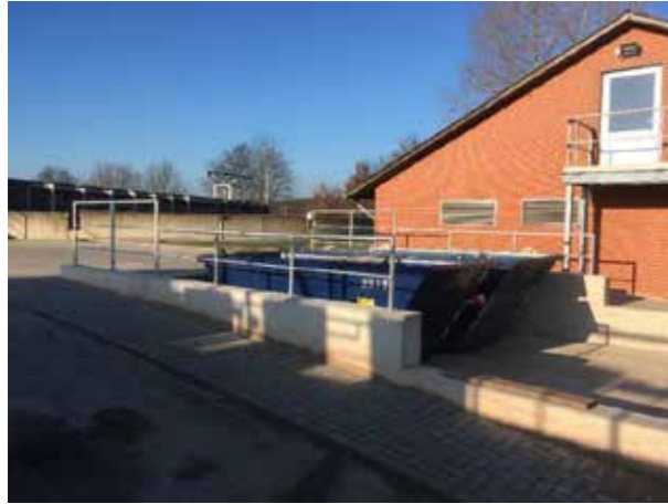
Bild: links erhöhte Befüllung; rechts ebenerdiger Abtransport
