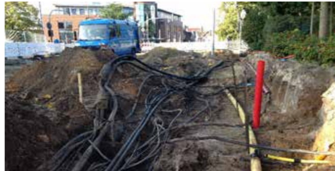
Oyther Straße - Versorgungsleitungen während der Neu- und Umverlegung (September 2019)
