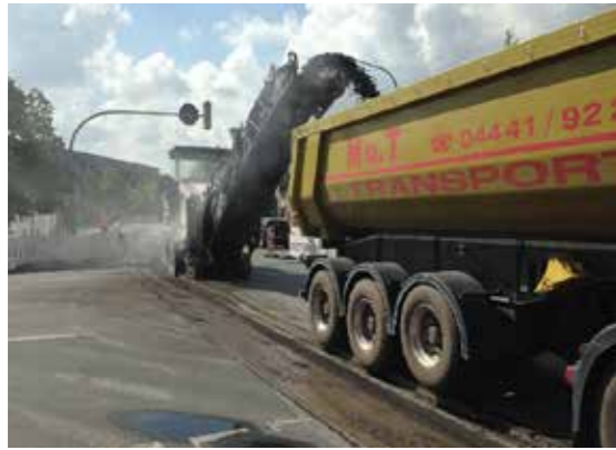
Kreuzung Ravensberger Straße Fräsarbeiten Asphaltdeckschicht (Juni 2019)
