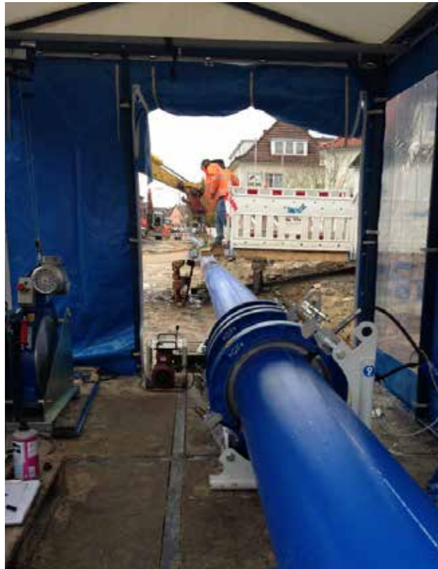
Oyther Straße - Stumpfscheißvorgang Trinkwasserhauptleitung (November 2019)
