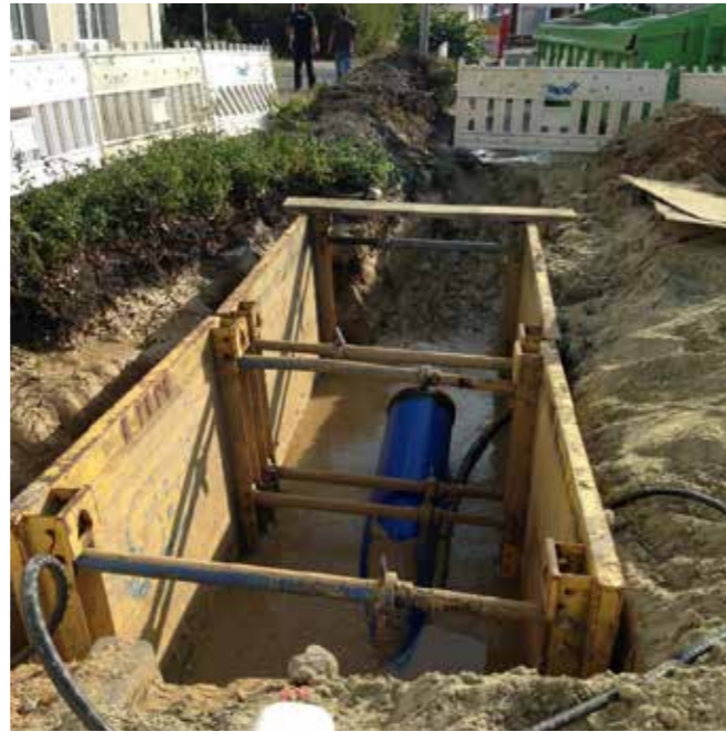
Oyther Straße - Startgrube Trinkwasserhauptleitung nach dem Einzug (Juli 2019)
