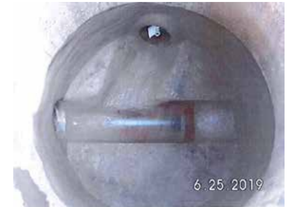
Schacht nach Sanierung
