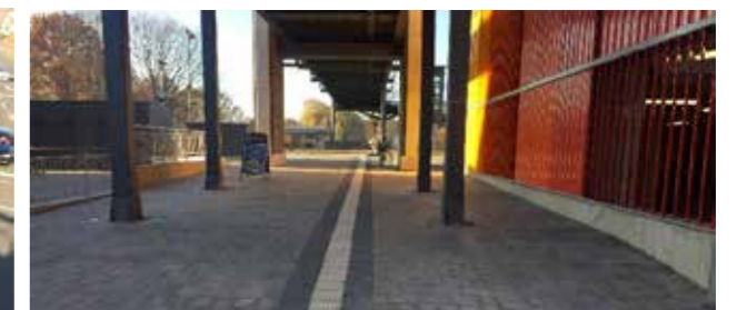
Mobilitätsstation - Taktiles Bodenleitsystem unterhalb der Geh- u. Radwegbrücke (Dez. 2019)
