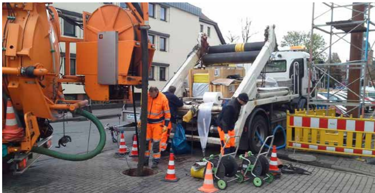
Vorbereitende Arbeiten für den Einzug des Inliners in den Schmutzwasserkanal
