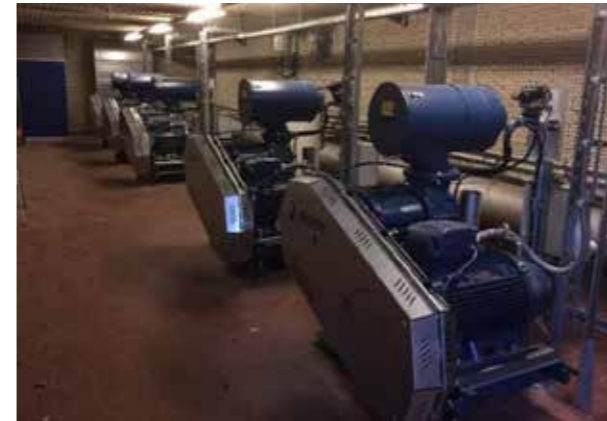
Fünf energieeffiziente Drehkolbengebläse und das automatische Ameisensäuredosiersystem
