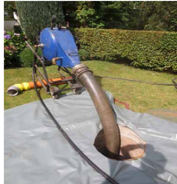
Drucktrommel zur Sanierung von Hausanschlussleitungen mittels Hausanschluss-Liner
