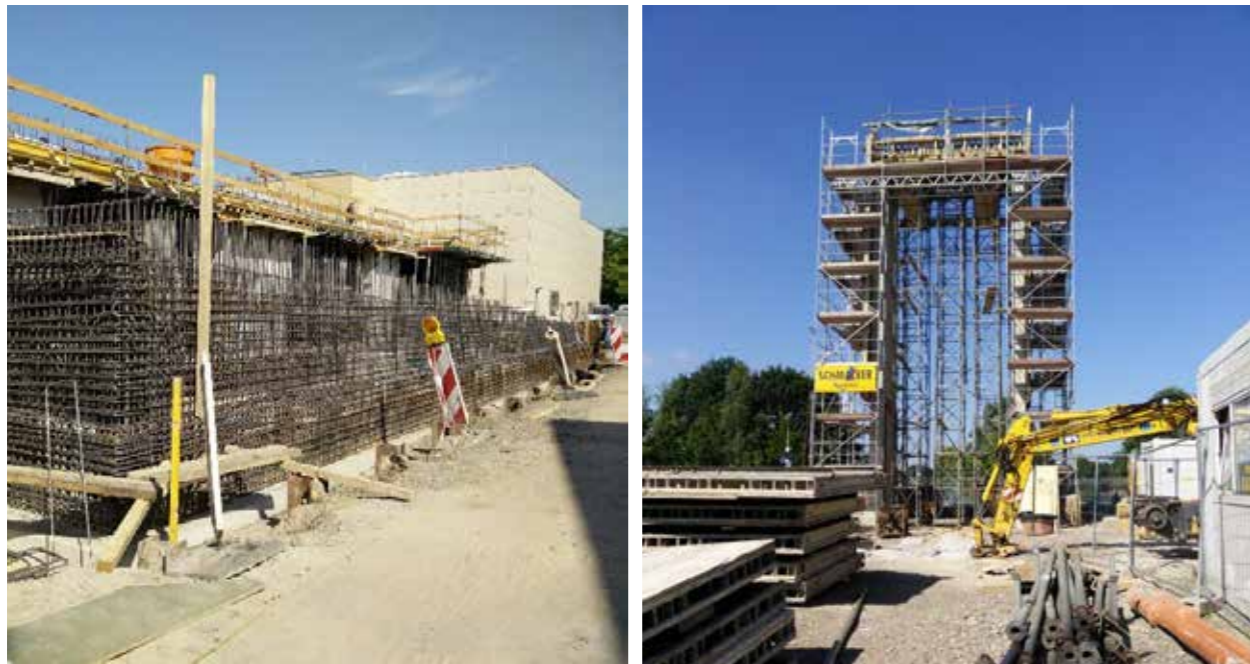
Bewehrung Brückenwiderlager Ost (Mai 2017)
