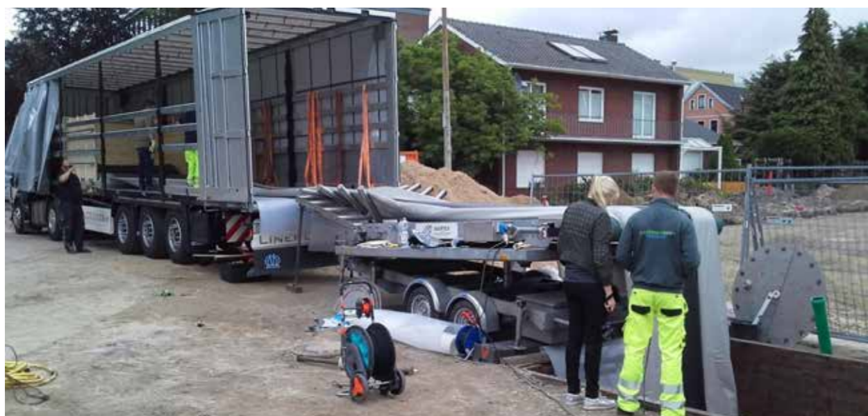
Vom Lkw direkt in das Kanalrohr: Mitarbeiter einer Kanalbaufirma ziehen den Gewebeschlauch in den sanierungsbedürftigen Regenwasserkanal.
