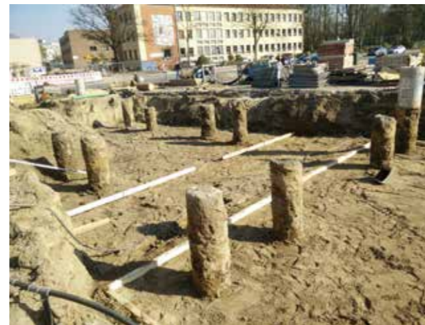
Baugrube Betonpylon (März 2017)
