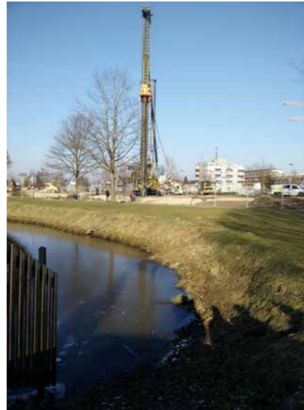
Bohrgerät westl. Zitadellenpark (Feb. 2017)
