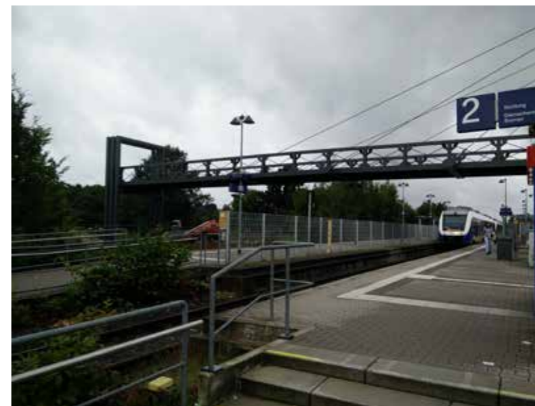
Nach Endmontage überspannt das Brückenelement die Bahngleise (Juli 2017)
