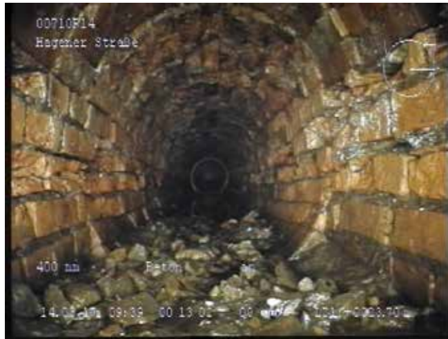
Gemauerter Bahndurchlass mit Rissen und Ausbrüchen Einschieben des Stahlrohres in den Bahndurchlass
