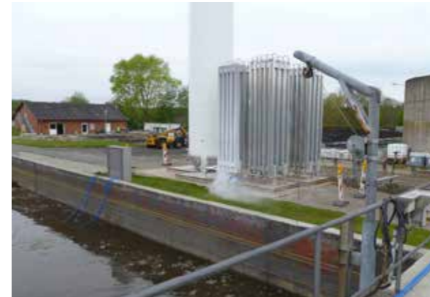
Flüssigsauerstoffanlage mit Verdampfeinheit und eingetragener Reinsauerstoff im „Ersatz-Becken“
