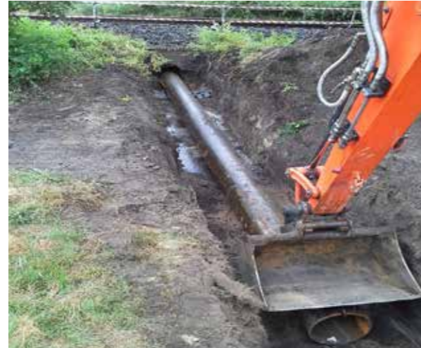
Gemauerter Bahndurchlass mit Rissen und Ausbrüchen Einschieben des Stahlrohres in den Bahndurchlass
