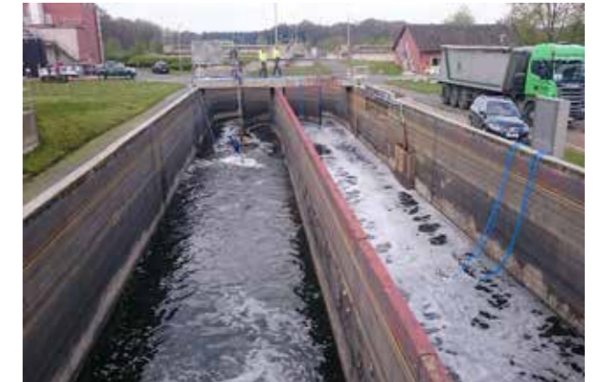
Flüssigsauerstoffanlage mit Verdampfeinheit und eingetragener Reinsauerstoff im „Ersatz-Becken“
