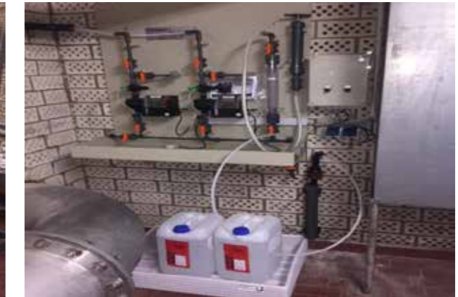
Fünf energieeffiziente Drehkolbengebläse und das automatische Ameisensäuredosiersystem
