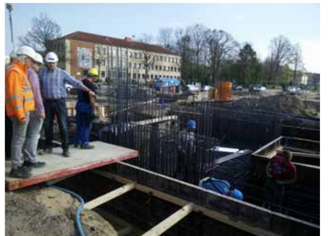
Baugrube Bewehrung Fundament Betonpylon (April 2017)
