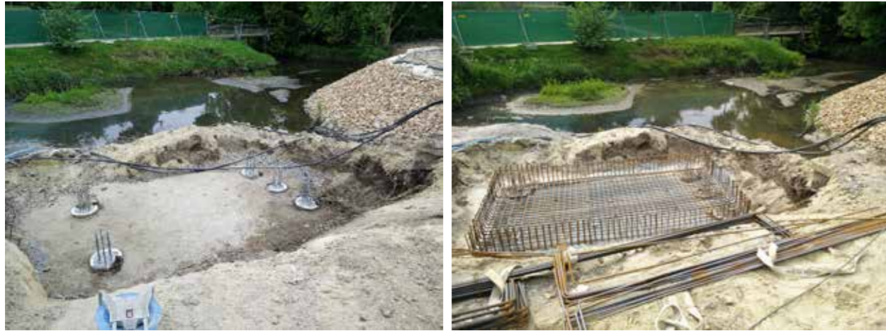
Anschluss Bohrpfähle an das künftige Fundament Brückenstütze Zitadellenpark (Mai 2017)
